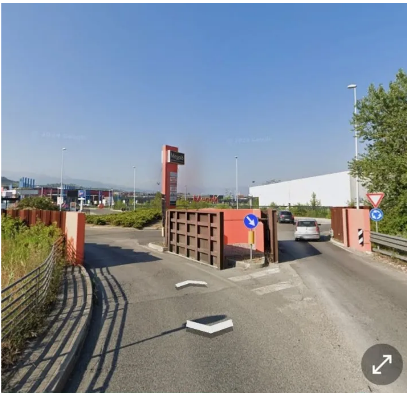
L'ingresso del centro commerciale chiuso da paratie idrauliche © Paolo Pileri
