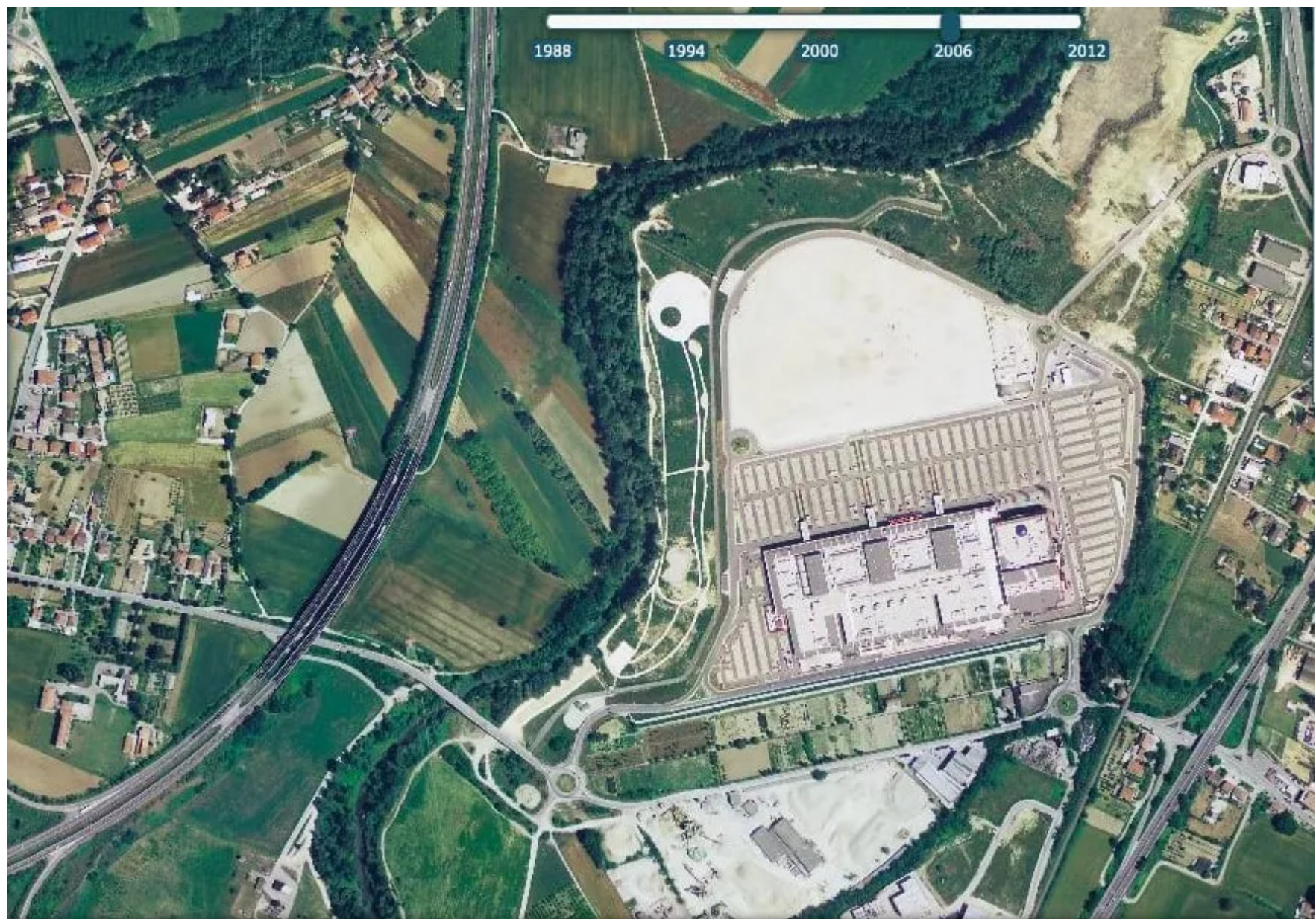
Sopra, l'area adiacente al fiume Pescara nel 2000 prima della costruzione del centro commerciale. Sotto, la stessa aerea nel 2006 dopo la fine dei lavori © Paolo Pileri
